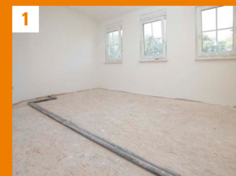
1 Verlegen des Randdämmstreifens Laying edge insulation strip
